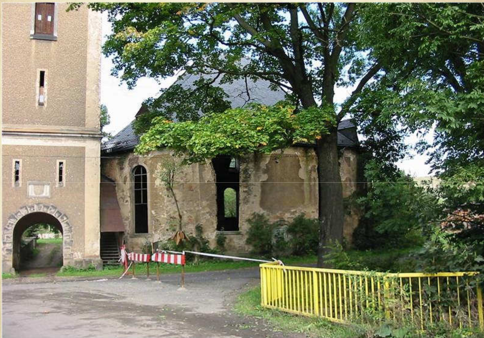
Rozbiórka kościoła ewangelickiego
