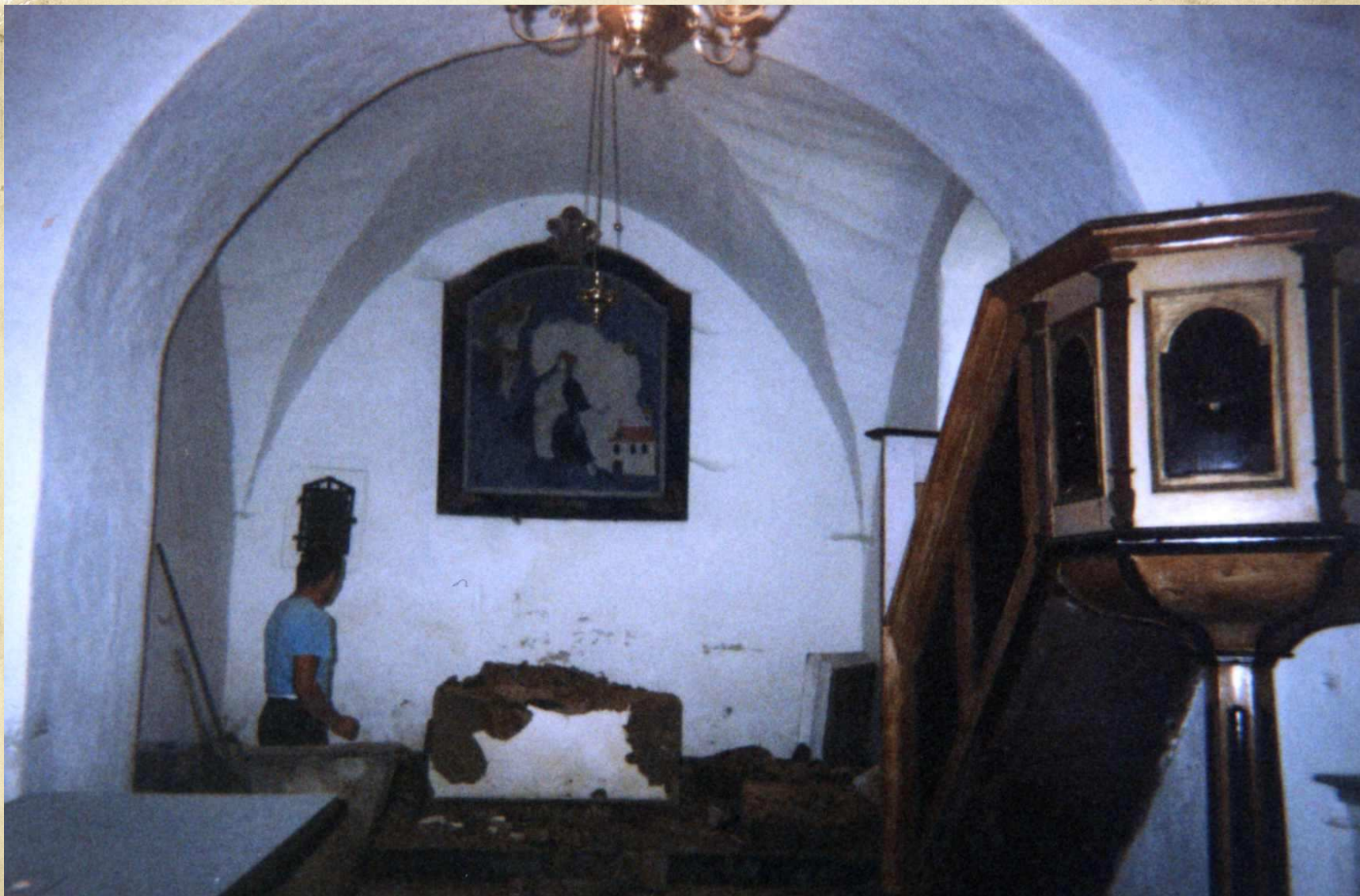
Remont wnętrza kościoła Św. Jadwigi Śląskiej w Chrośnicy
