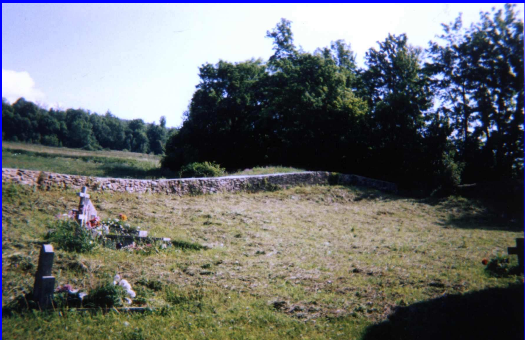
Chrośnica – mur po naprawie
