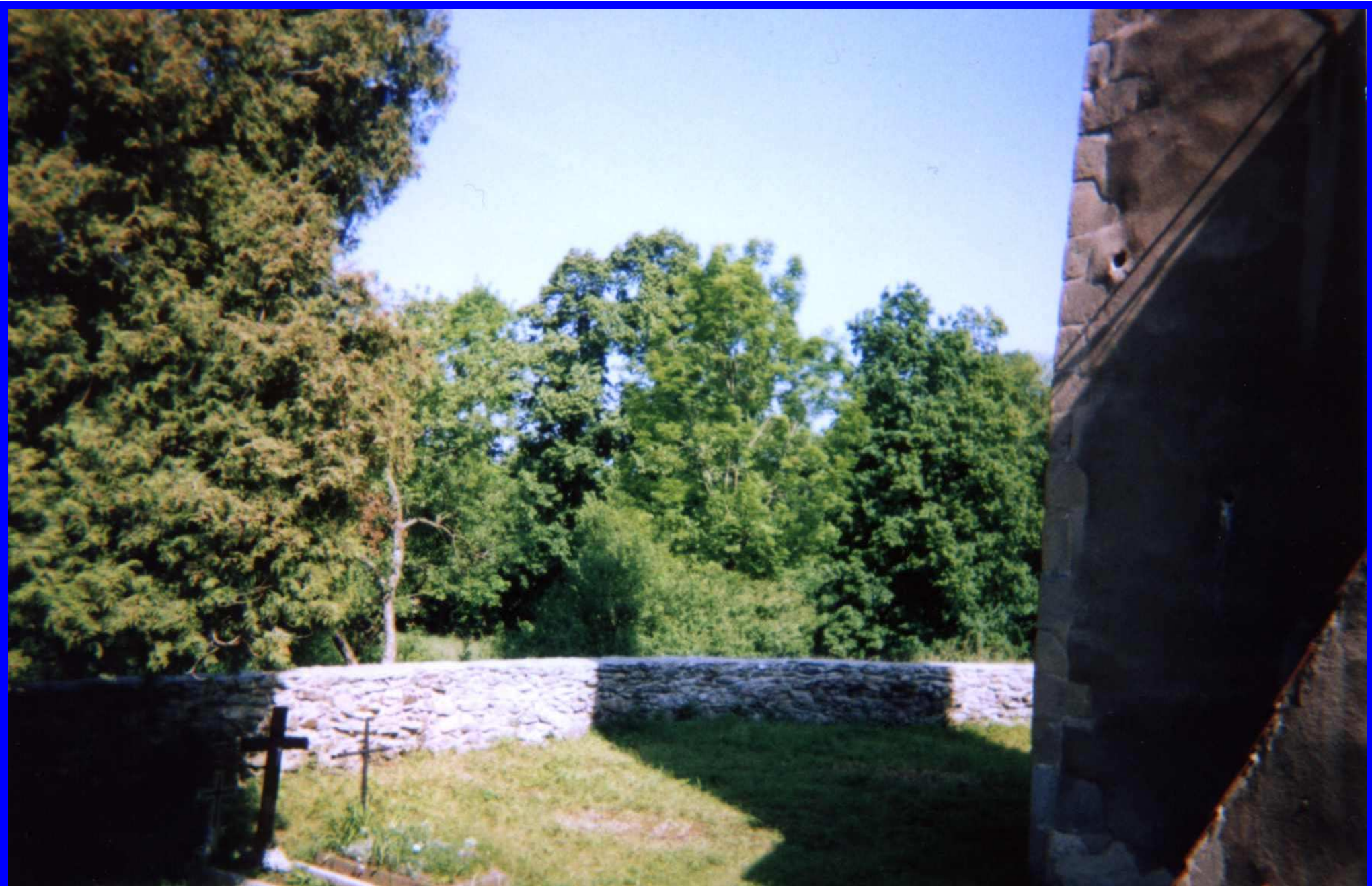
Chrośnica – mur po naprawie
