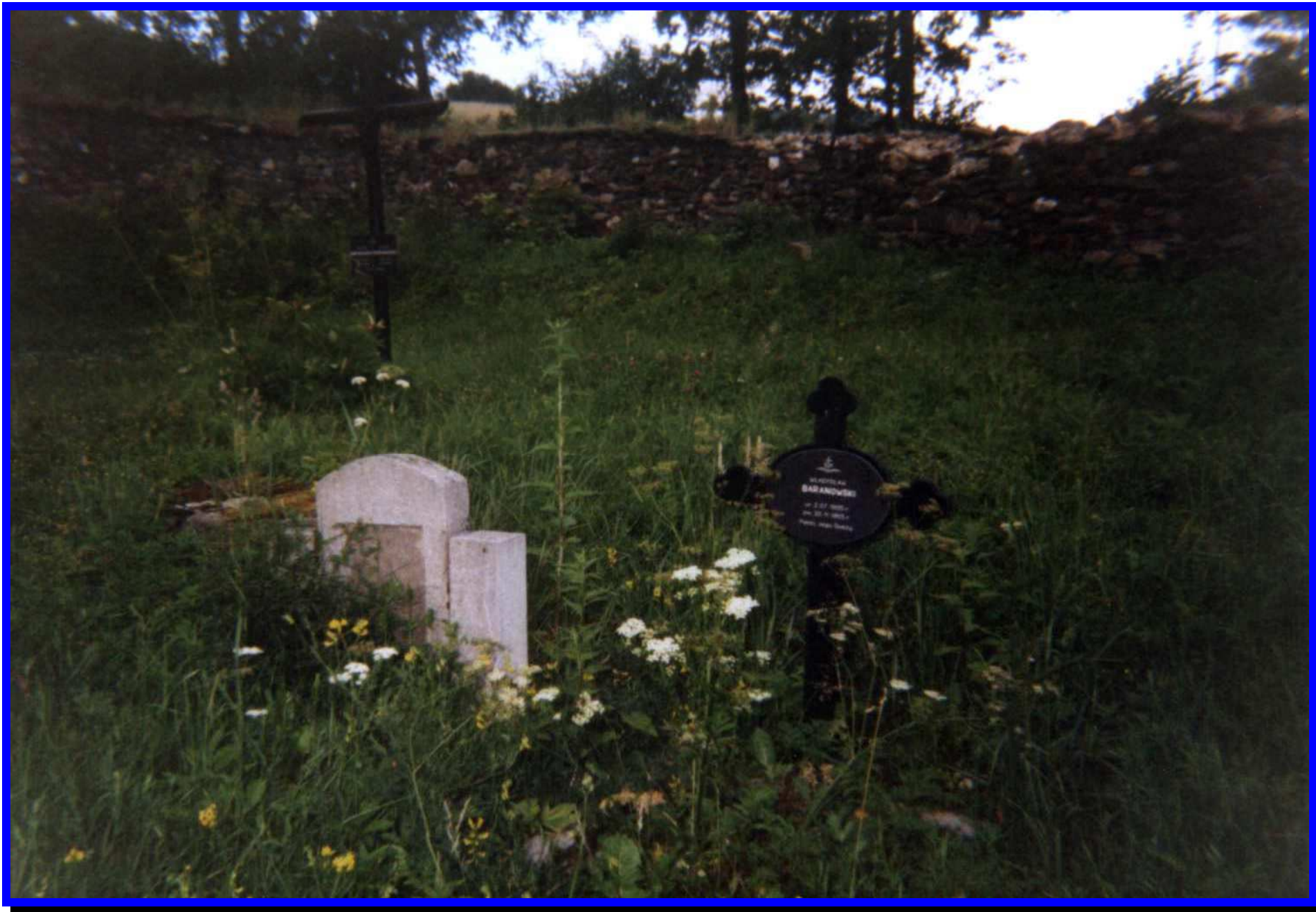
Chrośnica - Mur przed naprawą
