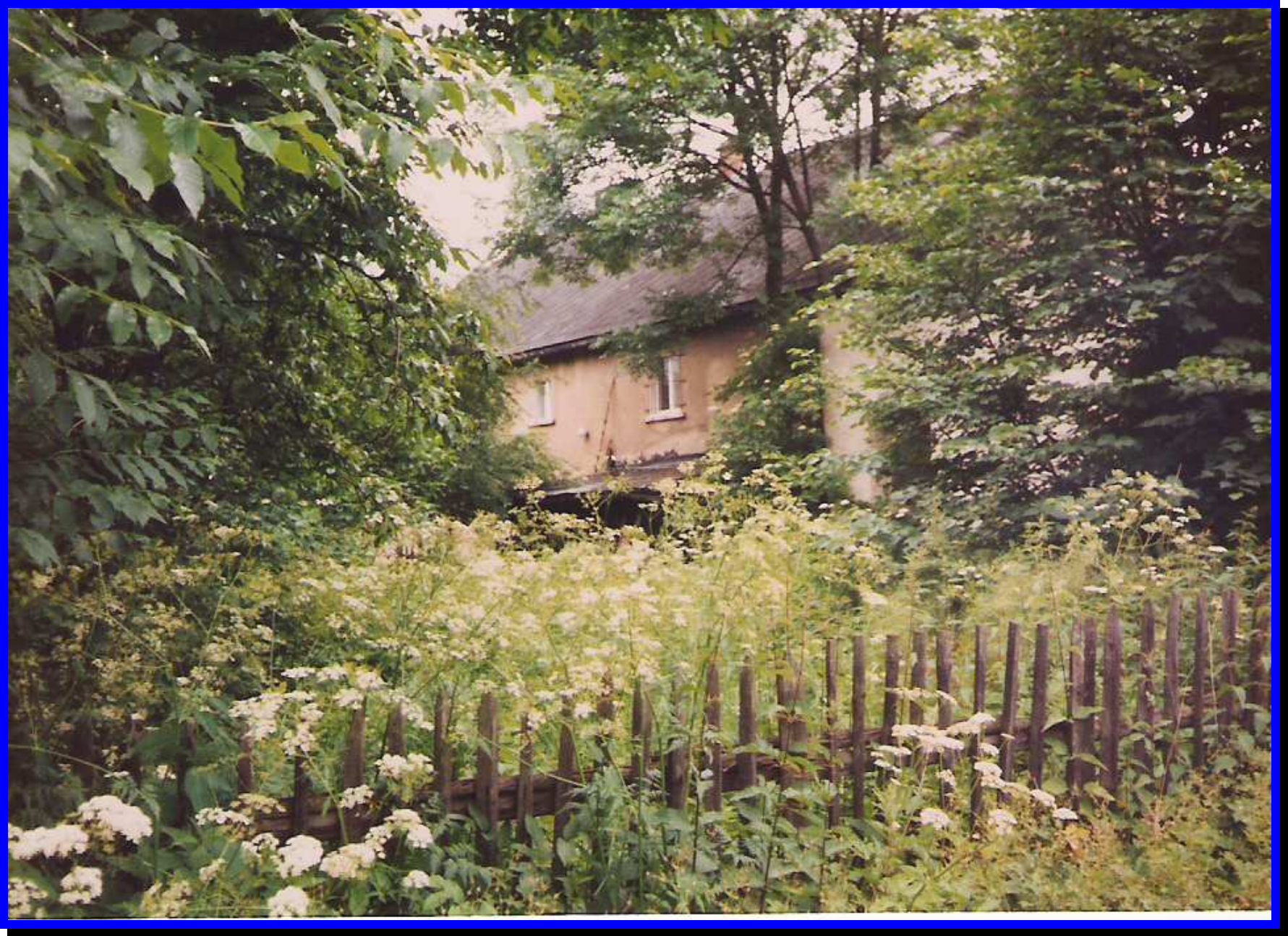
Prace remontowe plebanii w Czernicy.
