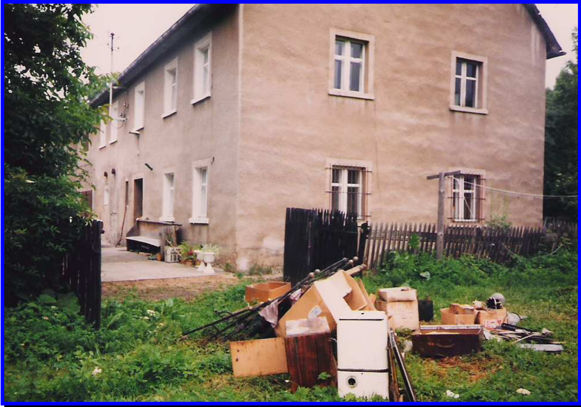
Prace remontowe plebanii w Czernicy.
